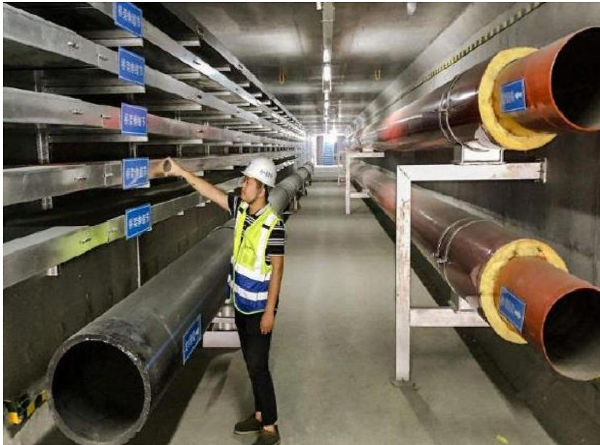
建成后，水、电、通信、燃气等管线将全部集中到地下管廊中。综合管廊一般在地下6到10米处，和地铁等其他地下建筑有效错开，不会影响其他地下设施的建设和运行。
